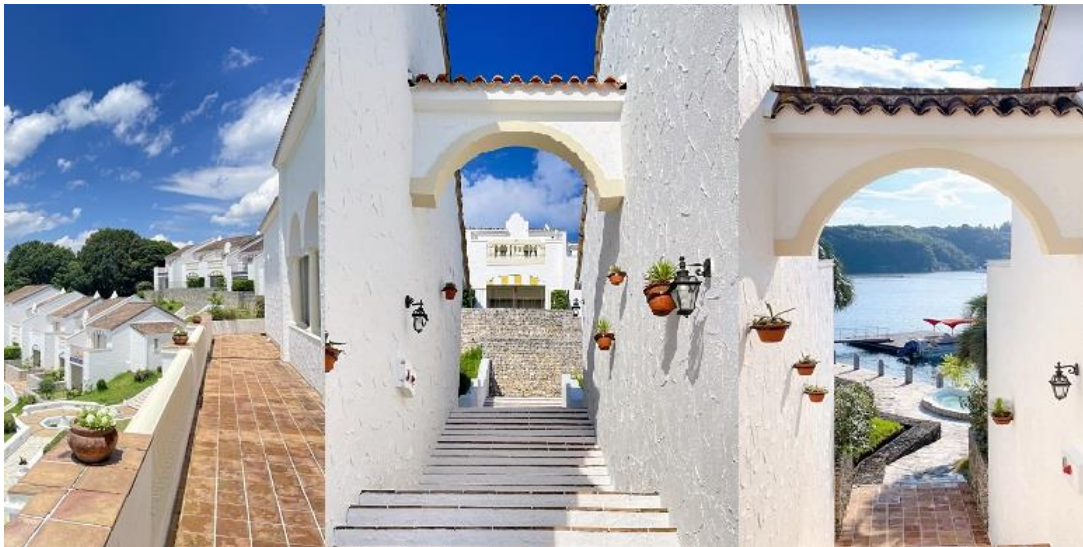
外壁塗装工事が終了した箇所の一例
